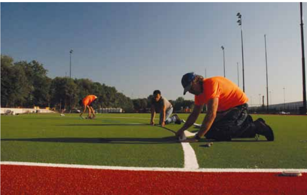
De stip en cirkellijnen worden altijd in het veld gelijmd.
