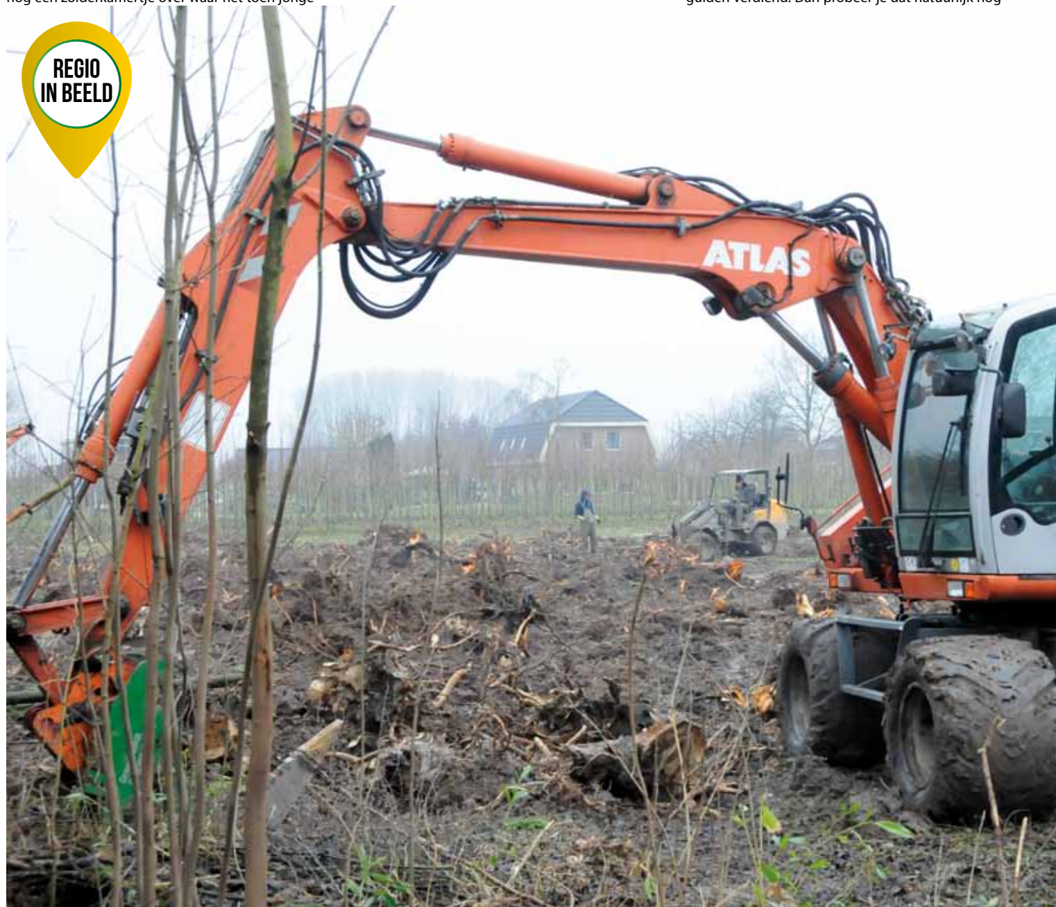
Aanleg van een nieuw containerveld.
